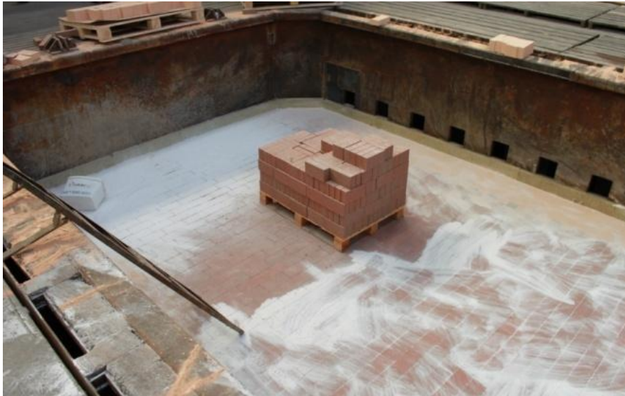
Slika 14. Elektrolitičke ćelije (elektrolizeri) (a) elektrolitičke ćelije, (b) postavljanje izolacione opeke u elektrolitičku ćeliju
